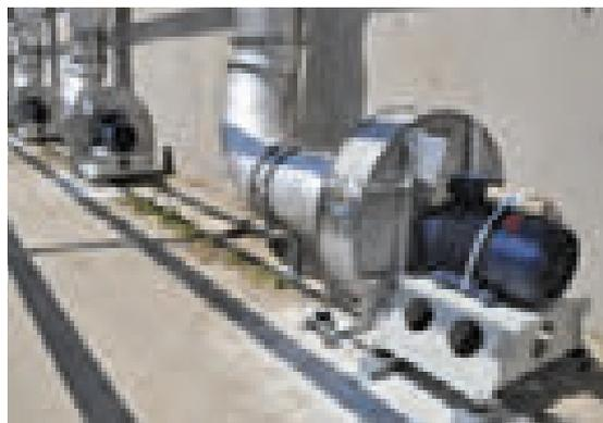
Statt des aktuell gültigen EU-Effizienzstandards IE3 verbaut die KRO in der neuen Anlage ausschließlich Motoren der neuen und noch besseren Effizienzklasse IE4. Damit werden noch einmal etwa 10 Prozent CO<sub>2</sub> gegenüber dem geltenden Standard eingespart.
